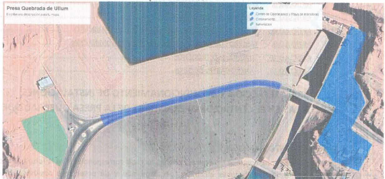
Figura 1. "Presa de Embalse Quebrada de Ullum".
