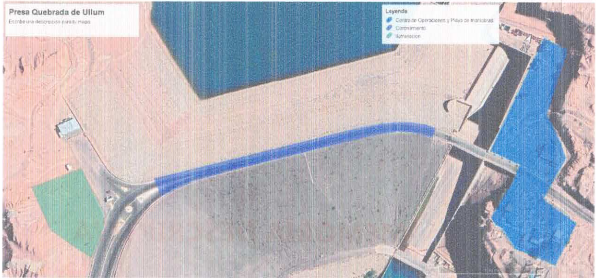
Figura 1. "Presa Quebrada de Ullum".
