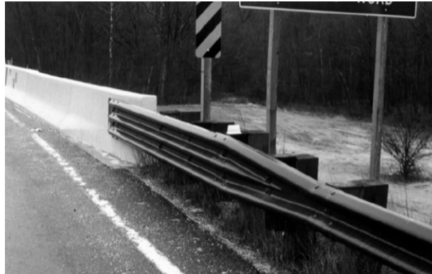
Ejemplo de Conexión con viga W
