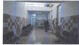
Revestimiento a demoler
